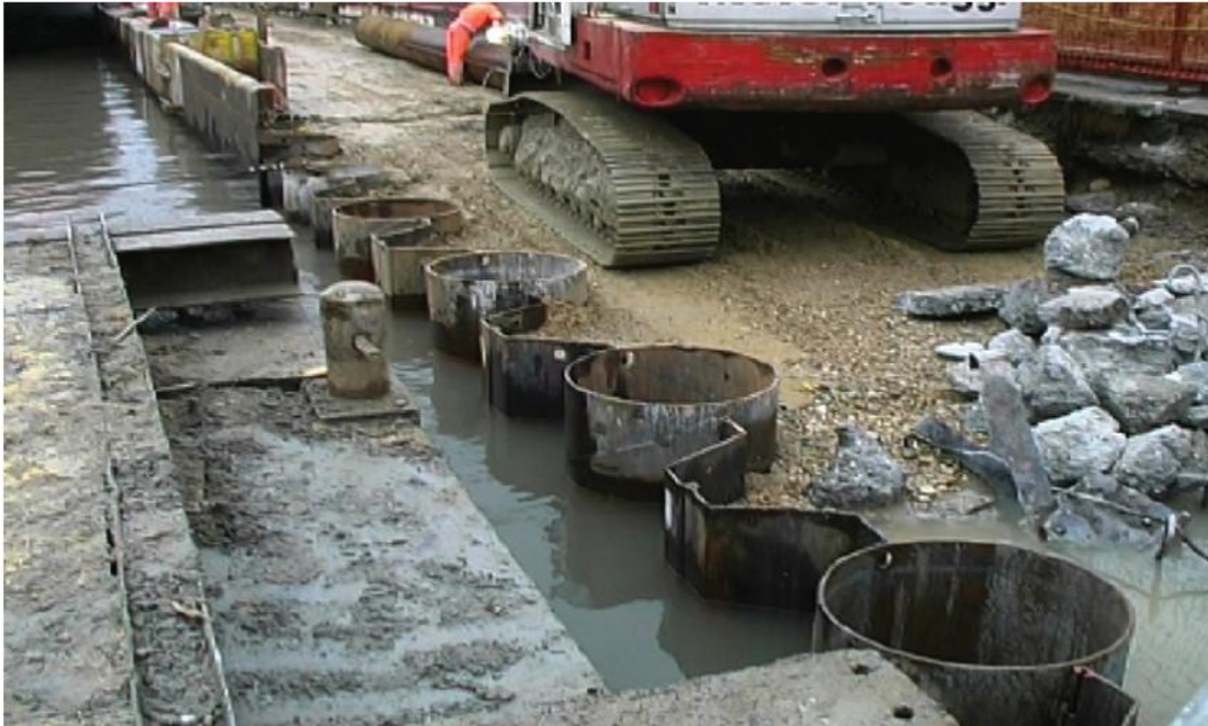
Комбинированная шпунтовая стенка с применением шпунта Ларсена профиля Z с соединительными замками L8.
