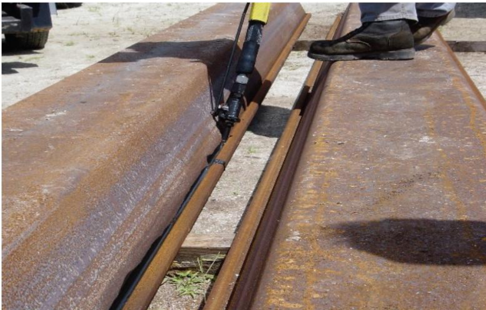
Нанесение герметизирующего состава на соединительный элемент замка шпунта.
